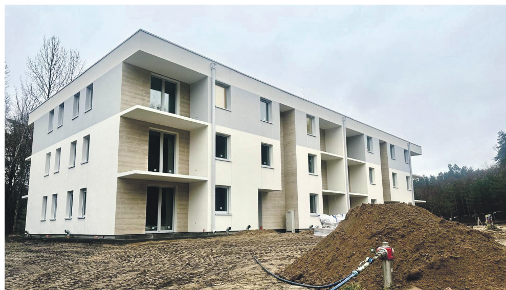
W dwóch budynkach znajdować się będzie 48 mieszkań dwu- i trzypokojowych
