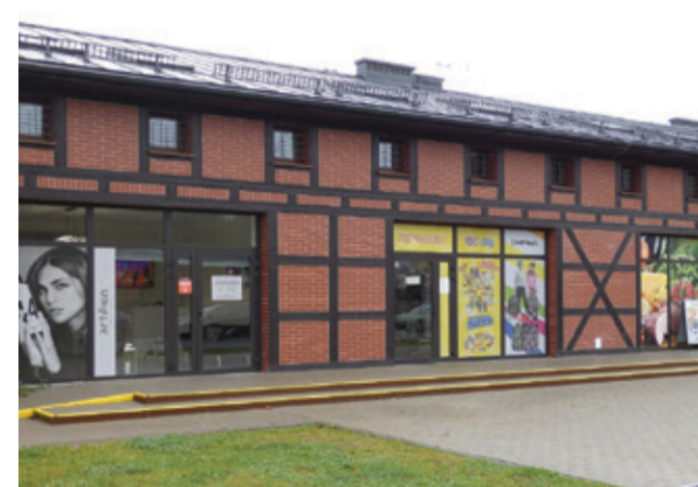
Nowe punkty handlowo – usługowe prężnie działają w budynkach przy ul. Niepodległości.
