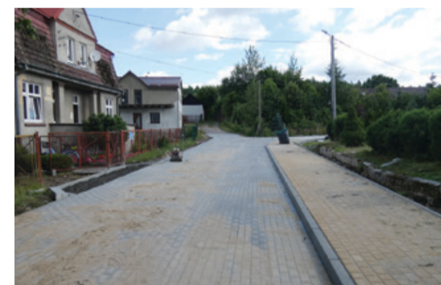
Prace modernizacyjne w Barcinie.
