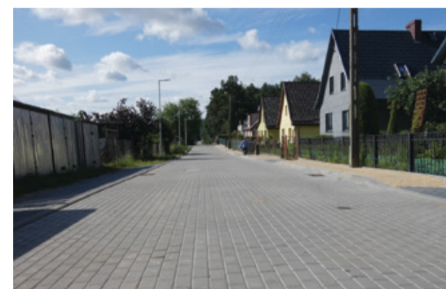
Pierwsza część modernizacji ul. Słowackiego została już zakończona.
