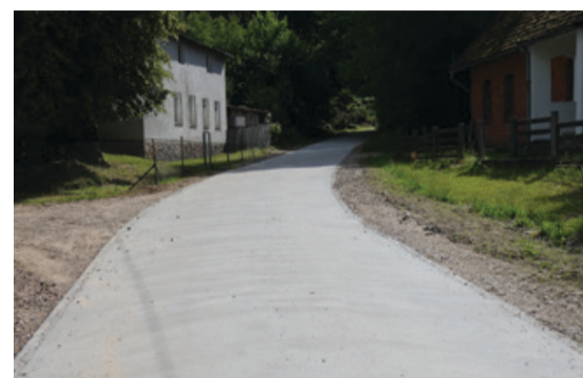
W Żelicach prace zostały już zakończone.
