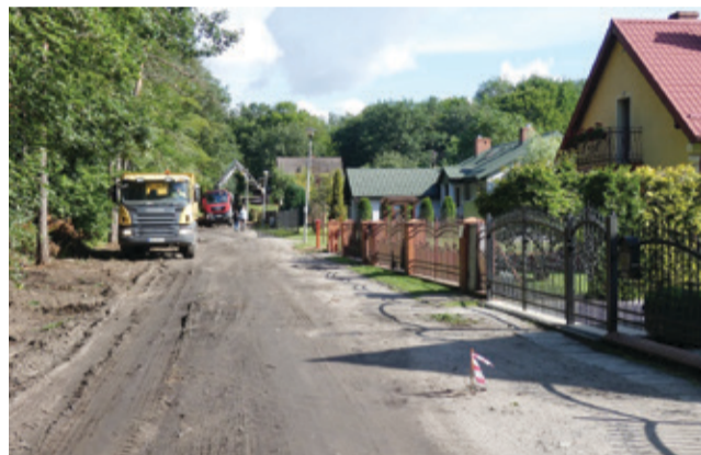
Rozpoczęcie prac przy ul. Sosnowej w Kępicach.
