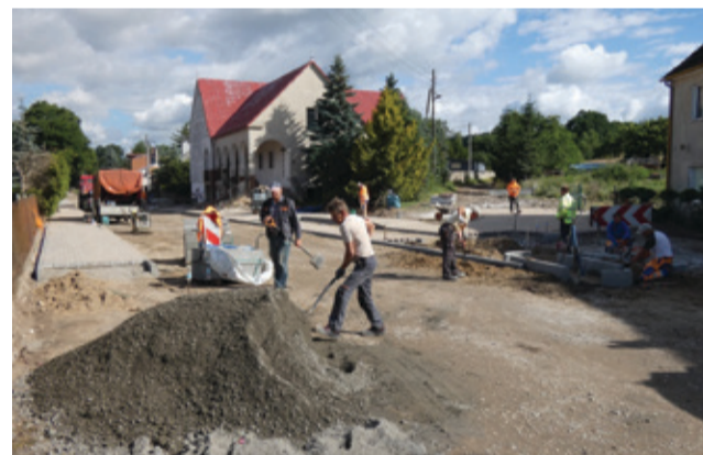
Prace modernizacyjne trwają także w Warcinie.
