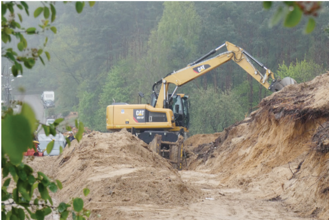
Rozpoczął się kolejny etap prac modernizacyjnych przy ul. Słowackiego w Kępicach.
